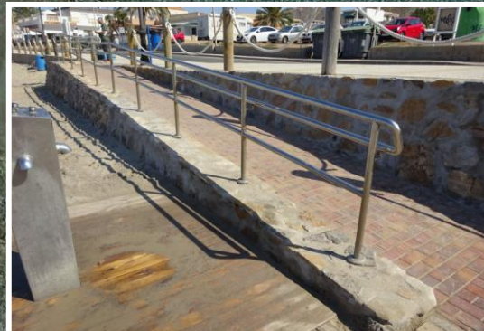
5 Rampa de acceso
