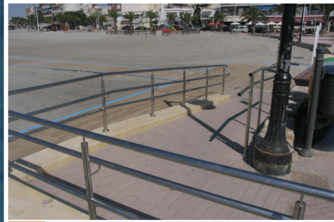
4 Rampa de acceso
