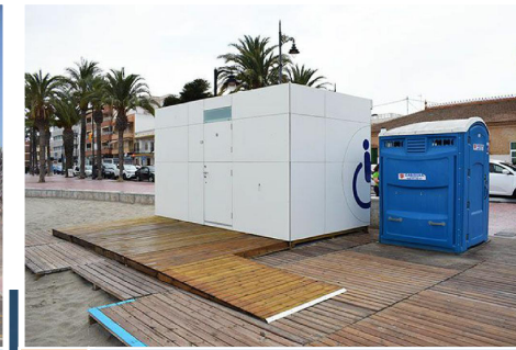
3 Aseo y vestuario (Clausurados)
