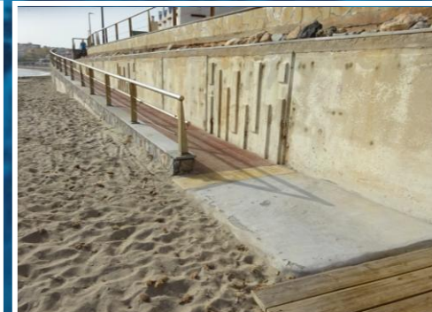
4 Rampa de acceso
