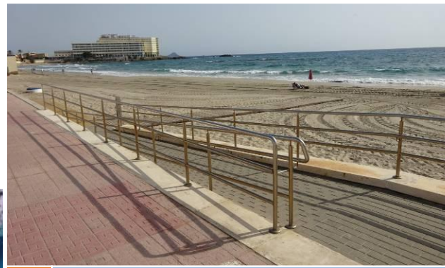
4 Rampa de acceso
