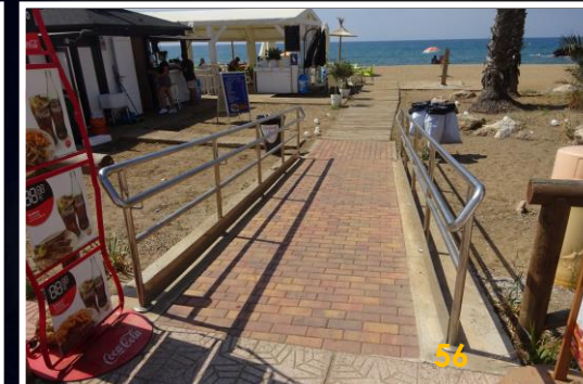
4 Rampa de acceso
