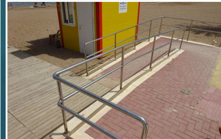
5 Rampa de acceso
