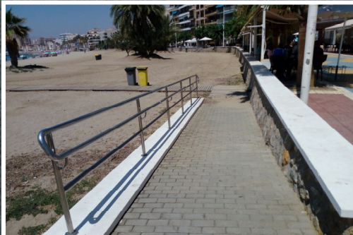
3 Rampa de acceso
