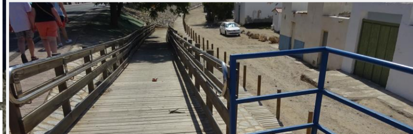
5 Rampa de acceso
