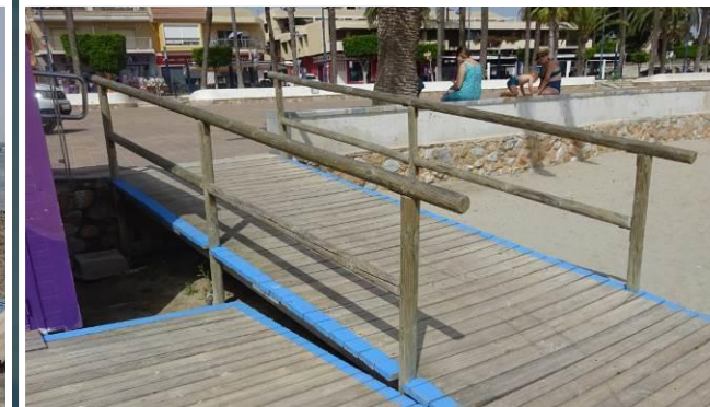
5 Rampa de acceso
