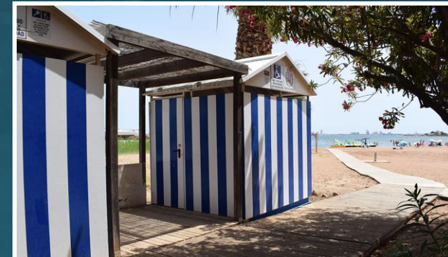
3.1 Aseo y vestuario (Clausurados)
