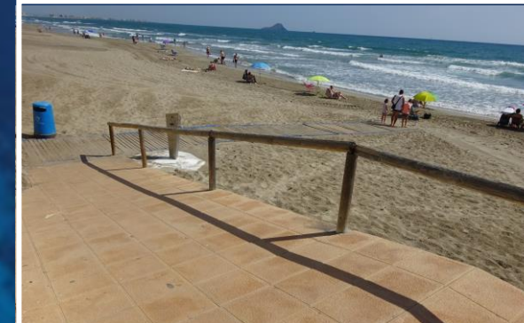
3 Rampa de acceso
