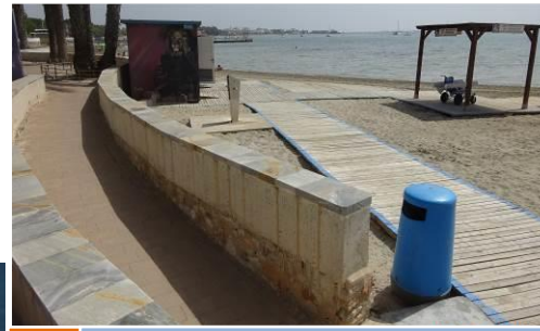
6 Rampa de acceso
