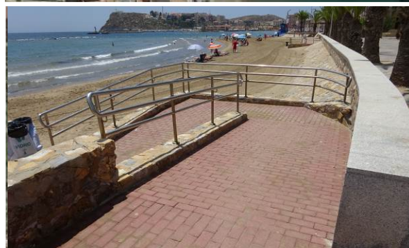
4 Rampa de acceso
