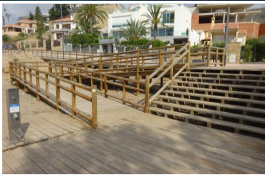
4 Rampa de acceso
